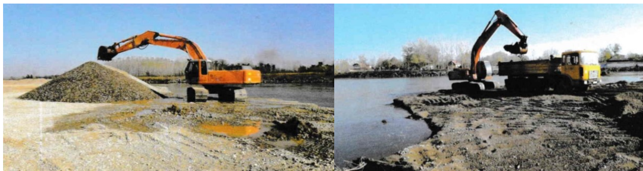
Слика бр. 8: Лица затечена у вађењу речних наноса са леве обале реке Дрине током спровођења заједничког надзора
